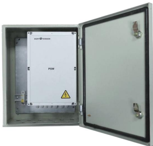
Рисунок 7.3 - Монтаж коммутатора в уличном шкафу.
